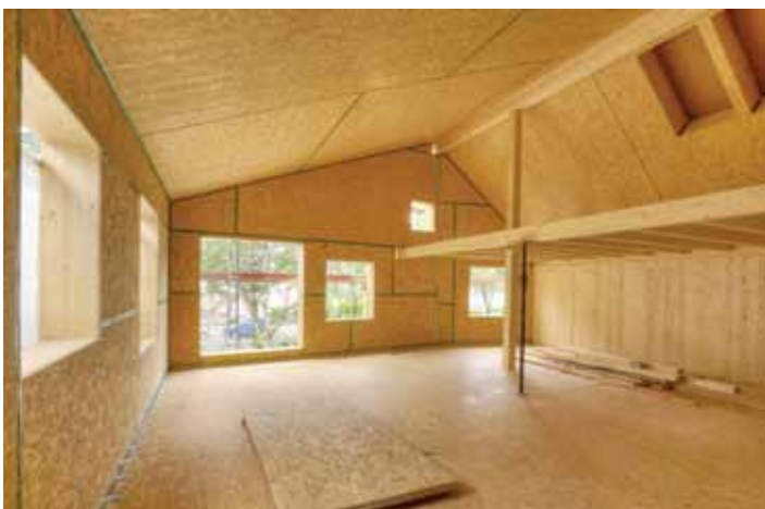
OSB-Platten gelten als Multitalente, sie werden außen und innen eingesetzt und hier vor allem, um eine dampfdichte Ebene herzustellen
