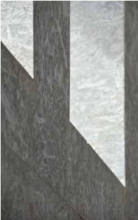
Knapp 2.500 m<sup>2</sup> SterlingOSB3-Platten in der Ausführung Spezial wurden verwendet, um den knapp 22 Meter hohen Treppenaufgang eines neuen Bürogebäudes in der Schweiz zu verschalen. Und nicht nur einfach zu verschalen: Der Bauherr, die Holzwerkstoffe Braun AG in Gossau im Kanton St. Gallen, hat sich ganz bewusst für dieses Material entschieden, um einen besonderen ästhetischen Eindruck zu erzielen.
