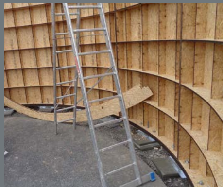
Die Konstruktion des Pavillons besteht aus gebogenen OSB-Platten Fotos: Norbord/Ackermann GmbH
